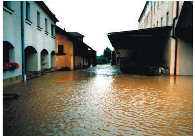
Langer Mühle 1997 - 45-jähriges Hochwasser
