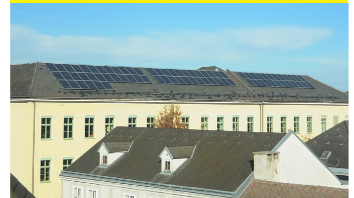
Photovoltaik-Anlage auf dem Schulgebäude, © Gemeinde Ober-Grafendorf
