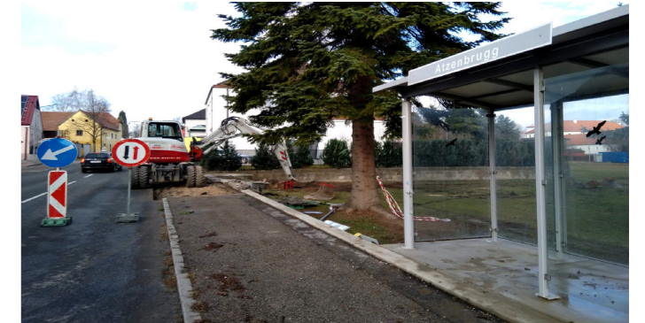
Vorarbeiten für die 2. Zufahrt zum neuen Kindergarten - ohne Verkehrskonzept für die Anbindung an die B43
