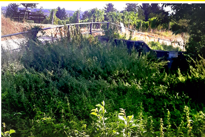
Verwachsenes Auffangbecken in Trasdorf
